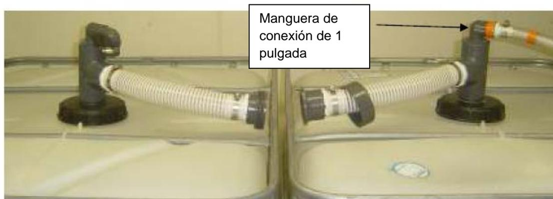
Figura 32: Posición de los accesorios superiores de la T1 y T2 y la manguera de conexión del T1
