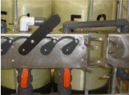
Figura 19: Abrazaderas del Clorador
