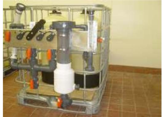
Figura 20: Clorador de Pastillas ajustado por 2 abrazaderas.
