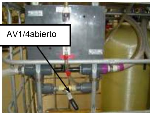
Figura 1: Válvula conductora de aluminio, \frac{1}{4} abierta
